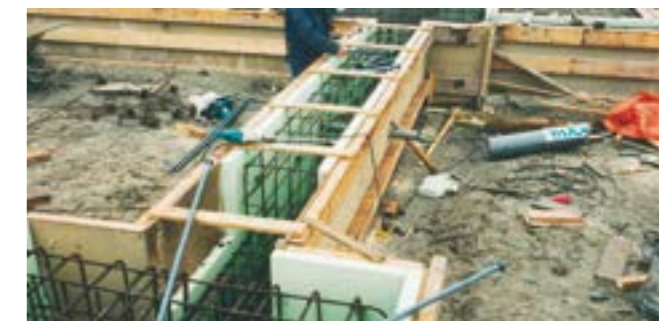
Fig. 27: Cassaforma con Styrodur®.
