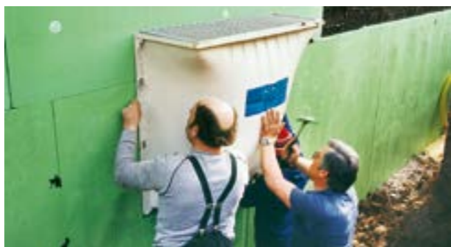
Fig. 24: Montaggio del lucernario nell'isolamento perimetrale.
