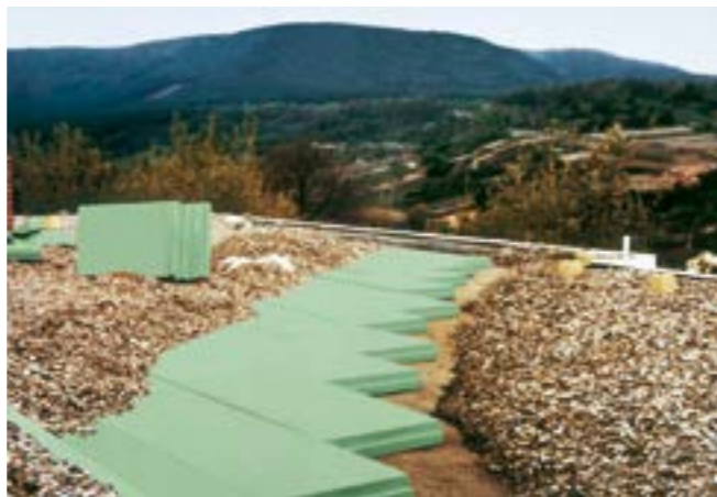
Fig. 18: Tetto rovescio risanato come struttura di tetto-plus.
