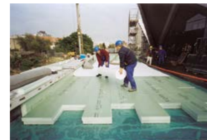
Fig. 16: Posa di Styrodur® sopra all'impermeabilizzazione del tetto.
