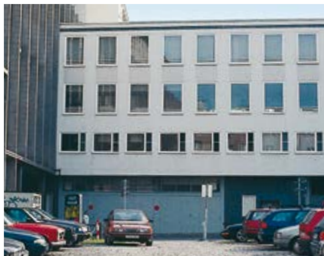
Fig. 5: Ripresa fotografica di un edificio per uffici.
