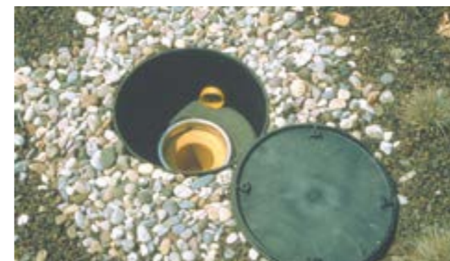
Fig. 10: Bocchetta di scarico del tetto.
