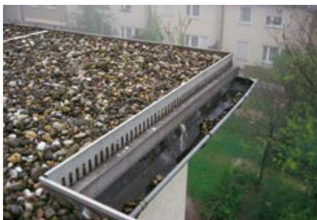
Fig. 19: Tetto a ghiaia.
