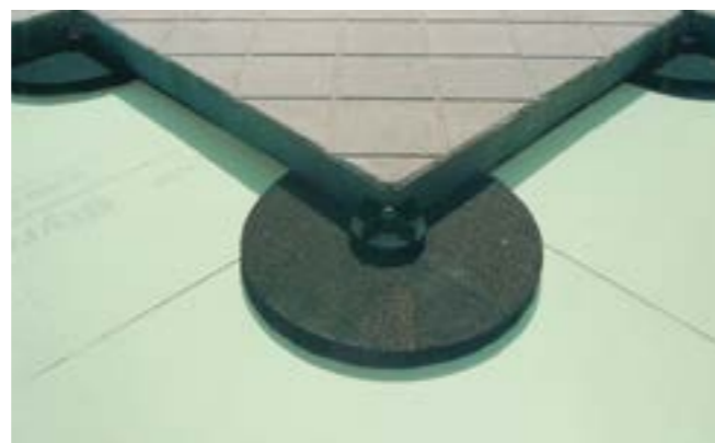
Fig. 44: Lastre di calcestruzzo posate su Styrodur® utilizzando un sistema di supporti.
