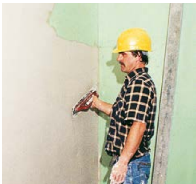
Fig. 29: Stesura del primo strato di intonaco adesivo a base di gesso; spessore dell'applicazione 10 mm.
