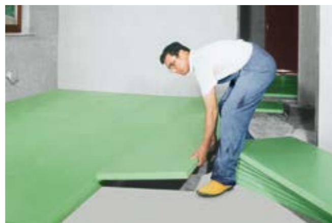
Fig. 18: Isolamento del pavimento della cantina.
