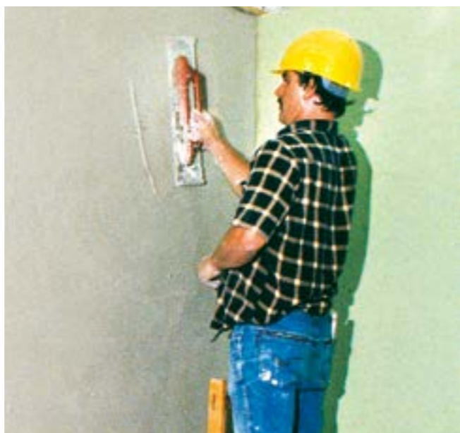
Fig. 31: Stesura del secondo strato di intonaco, spessore di circa 5 mm. L'applicazione dell'intonaco avviene fresco su fresco.
