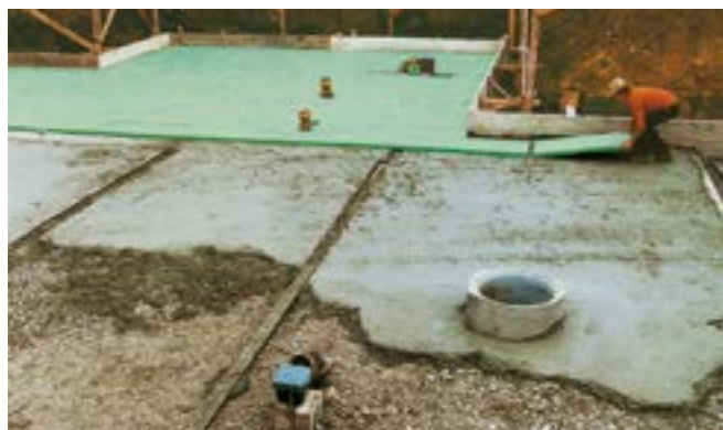
Fig. 6: Strato di protezione in calcestruzzo magro per la posa dell'isolamento del pavimento.
