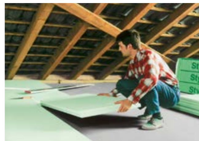
Fig. 10: Isolamento di un sottotetto con Styrodur®.
