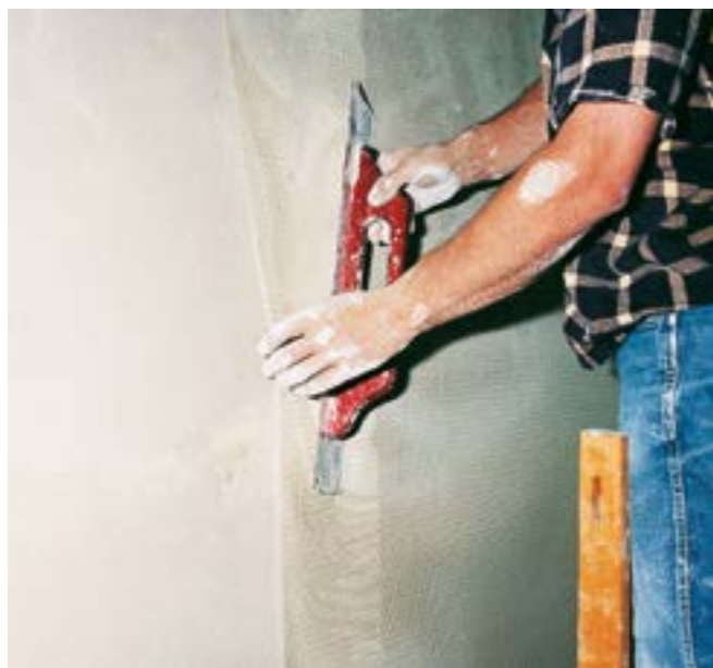
Fig. 30: Posa su tutta la superficie della rete di armatura in fibra di vetro. I teli di rete sono sovrapposti di circa 100 mm.
