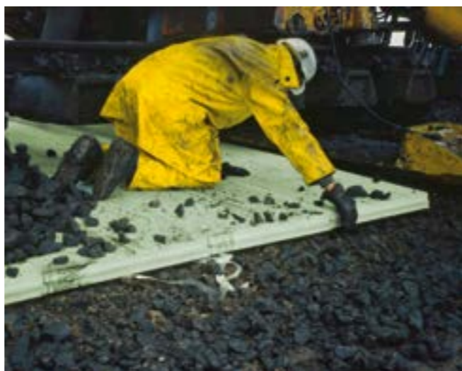
Fig. 9: Posa di Styrodur® nella massicciata ferroviaria.
