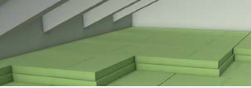
Isolamento del solaio non calpestabile
