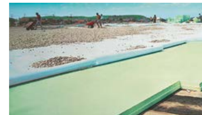
Fig. 11: Tetto rovescio con riporto di ghiaia.
