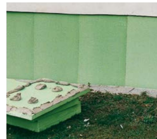
Fig. 28: Risanamento di una vecchia costruzione; incollaggio di lastre di Styrodur® 2800 C con procedura di giunzione a punti sul bordo.
