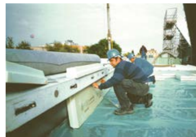
Fig. 15: Isolamento della veletta con Styrodur®.
