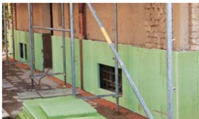
Fig. 17: Successivo isolamento dello zoccolo con Styrodur® 2800 C.
