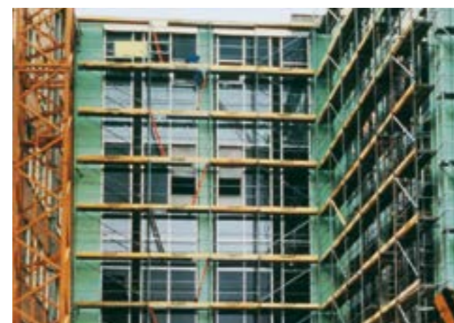
Fig. 7: Isolamento di ponti termici con Styrodur® 2800 C.
