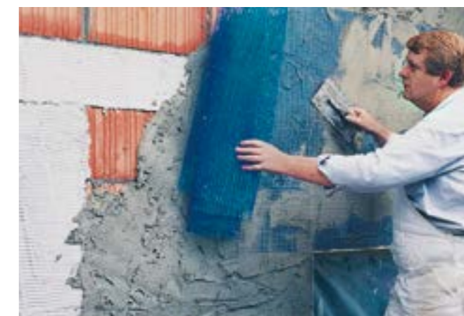
Fig. 22: Applicazione dell'intonaco di fondo e posa dell'armatura con rete in fibra di vetro sugli elementi strutturali in calcestruzzo isolati.
