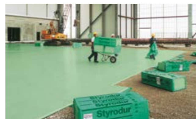
Fig. 21: Isolamento del pavimento di un capannone con Styrodur®.
