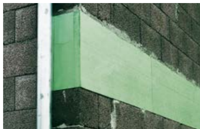
Fig. 2: Isolamento termico nel perimetro del solaio con Styrodur® 2800 C.
