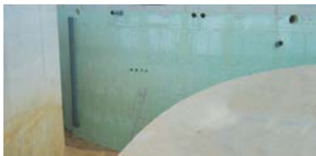
Fig. 1: Isolamento termico con Styrodur® di una parete di fermentatore in calcestruzzo armato.
