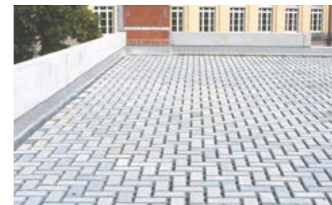
Fig. 49: Pavimentazione autobloccante in calcestruzzo su Styrodur®.
