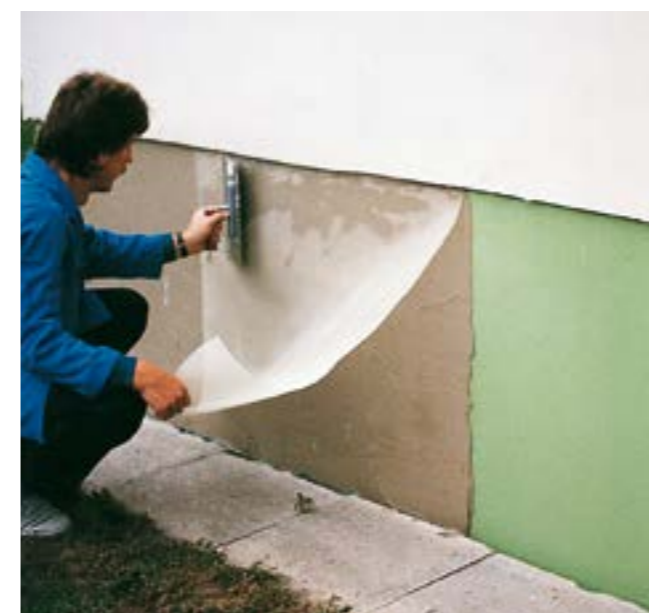
Fig. 26: Inserimento della rete in fibra di vetro nell'intonaco di fondo dello strato isolante dello zoccolo.
