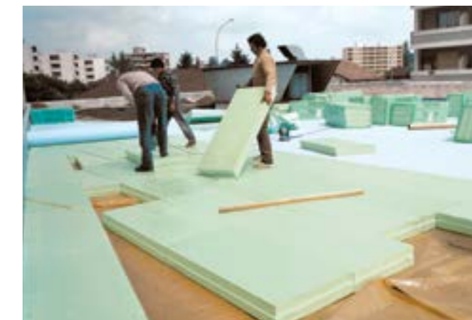
Fig. 14: Posa di Styrodur® per tetto-duo.
