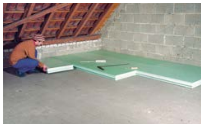
Fig. 2: Isolamento del sottotetto con Styrodur.
