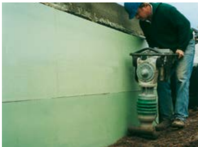
Fig. 30: Riempimento a strati dello scavo di fondazione e compattazione meccanica.
